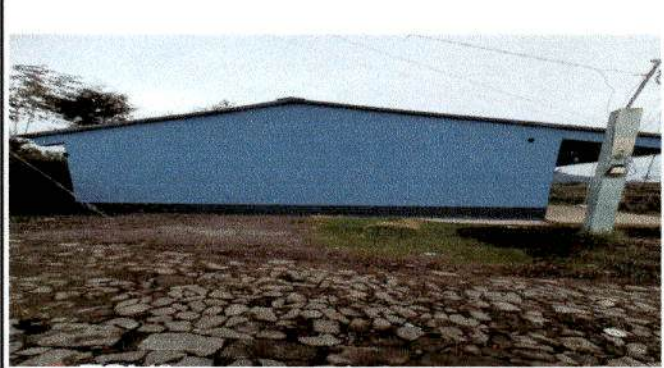
Foto 2: finalizacion de pintada y techo de aula No. 2 y 3
