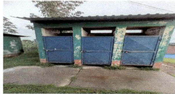
Foto 6: techo de los servicios sanitarios terminada
