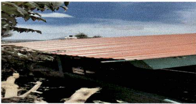
Foto 3: finalizacion del techo del aula No. 2 y 3
