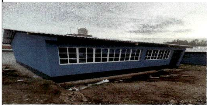
Foto 4: finalizacion de reparacion del aula No. 7
